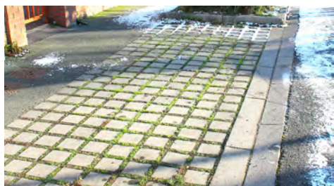
Parkings permettant l'infiltration des eaux de pluie
